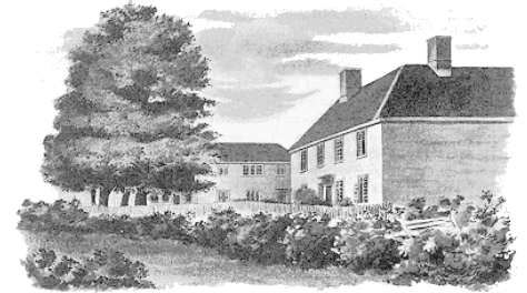
Presbytère de Stambourne
